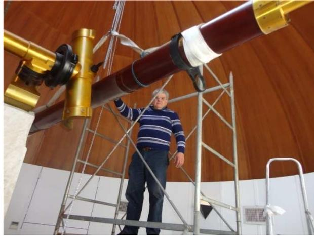
Fig. 1- Il tecnico Filippo Mirabello insieme al tubo del telescopio che viene calato giù dopo essere stato sganciato dal suo alloggiamento.
